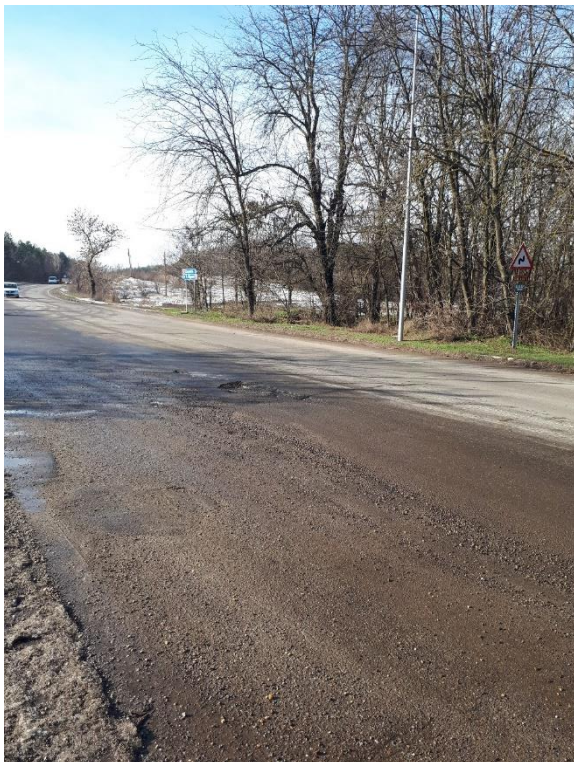
Fig. 1.2. 8 - Exemple de suprafețe carosabile în stare necorespunzătoare
